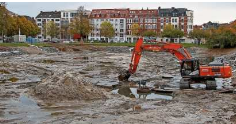
Vor einem Jahr wurde der Holzhafen entschlammt, die Uferböschung saniert und das Umfeld mit Bänken und Sitzsteinen erneuert.
